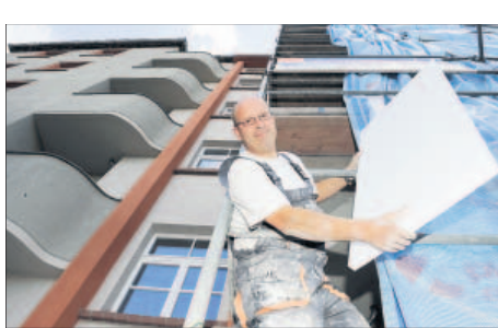
Maurer Thomas Gärtner verbaut Dämmplatten am Haus in der Fritz-Reuter-Straße 61. Foto: Steffen Unger
